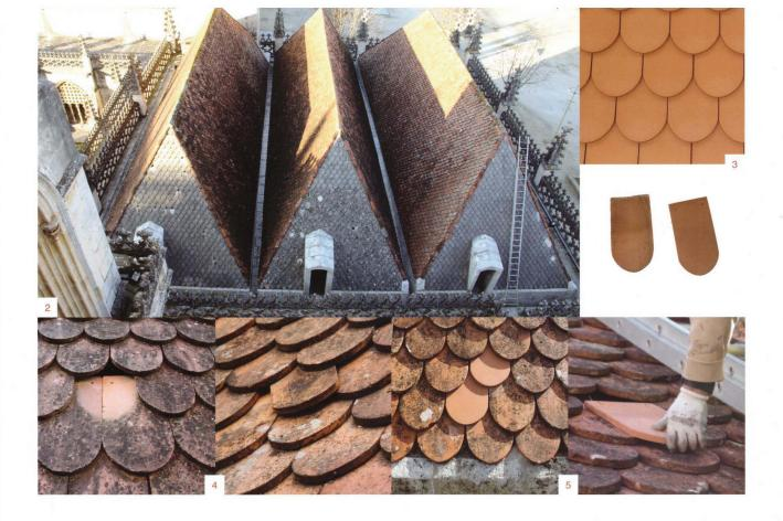
a causa das infiltrações de água, atuando ao nível das secções de escoamento em alvenaria e na substituição dos soletos calcários e cerâmicos, em falta ou deteriorados.
